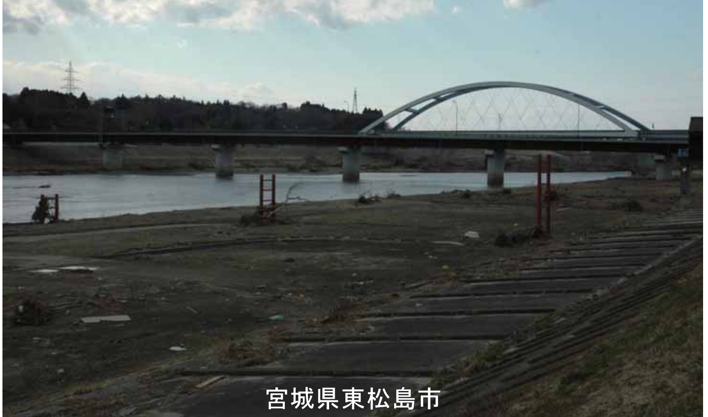
0106_2_018_012108_東松島市(広報)_2011.3.28_ 鳴瀬堰付近_小野から三陸自動車道鳴瀬奥松島大橋撮影
